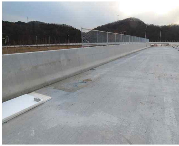
서오창 IC Ramp-A1교
